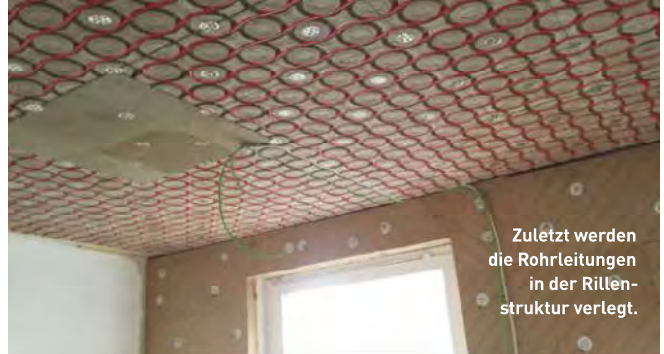
Insgesamt beträgt die Aufbauhöhe des Deckenheiz- und Kühlsystems inklusive Innendämmung 9,5 Zentimeter.
