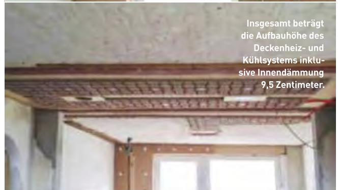
Zuletzt werden die Rohrleitungen in der Rillenstruktur verlegt.
