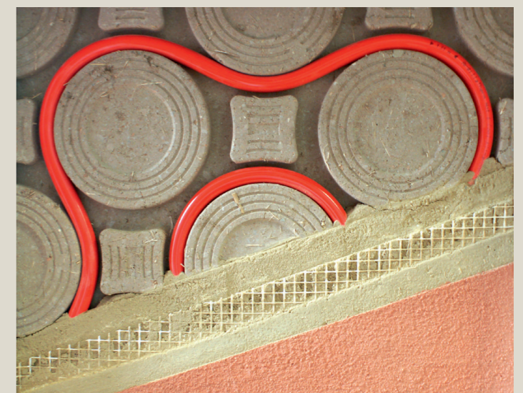
Die Rillenplatten mit den Rohren werden anschließend mit Lehmputz und Lehmfarbe beschichtet.
